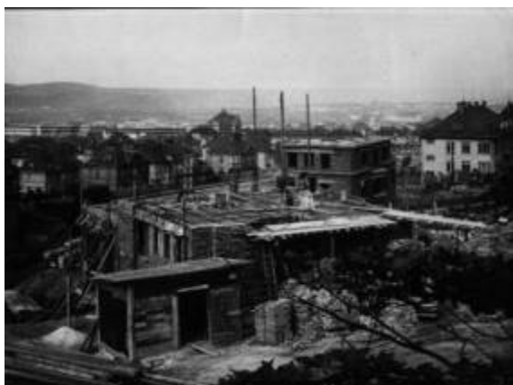
Staveniště Müllerovy vily, foto někdejší archiv firmy Pařík a spol., 1929
