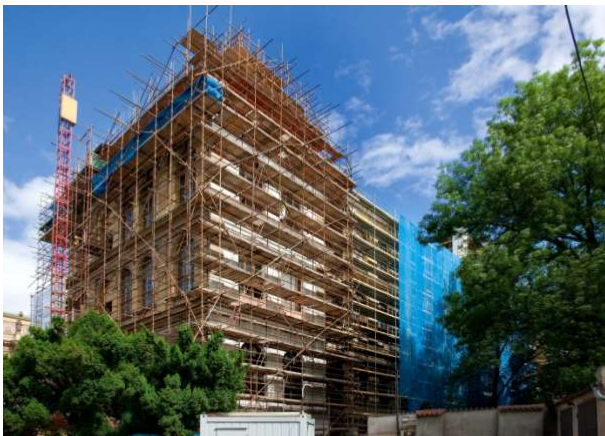
Historická budova Uměleckoprůmyslového musea prochází kompletní rekonstrukcí
