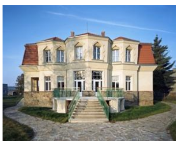
Bauerova vila – exteriér
